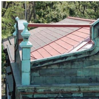
屋根の手前側、明るい色の部分が今回葺き変えた部分
